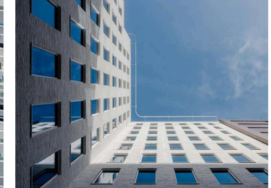
Mit dem bei diesem Projekt eingesetzten FINEO Hybrid wurde eine unvergleichliche Leistung in den Bereichen Wärme- und Schalldämmung erreicht. Durch die vielbefahrene Rue Belliard entsteht eine starke und unangenehme Lärmbelästigung.
